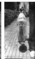
Manresa. Maig 1938. Bomba incendiària no explotada...
