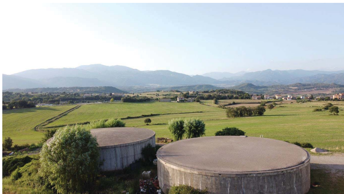
Fig. 2 Vista detall de les cobertes dels dipòsits
