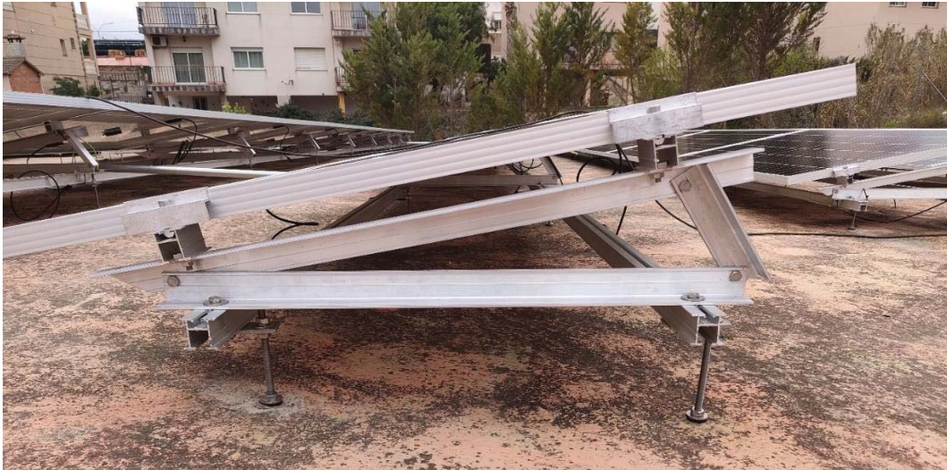
Fig. 7 Exemple de fixació de l'estructura
