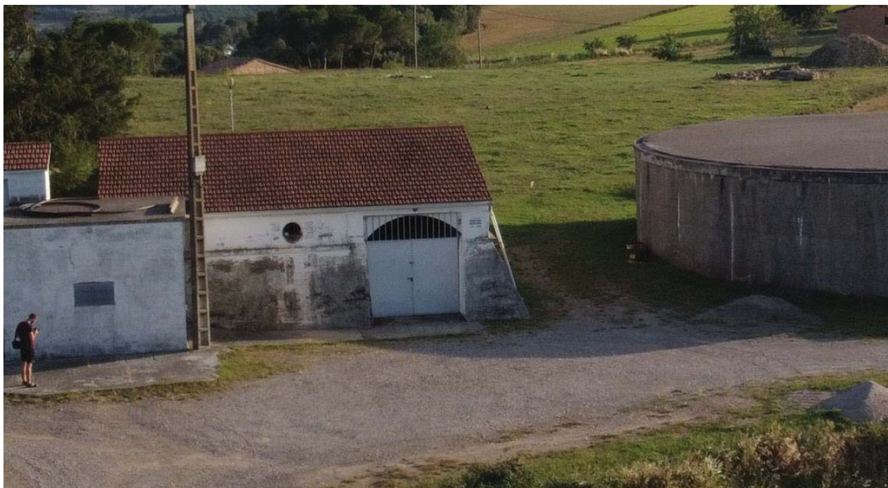
Fig. 3 Vista general ubicació armari d'inversors i comptadors + nova escomesa
