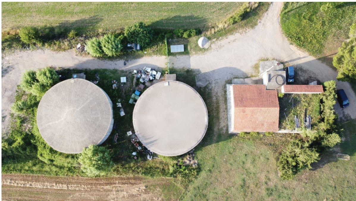
Fig. 1 Vista general de l'emplaçament de la instal·lació
