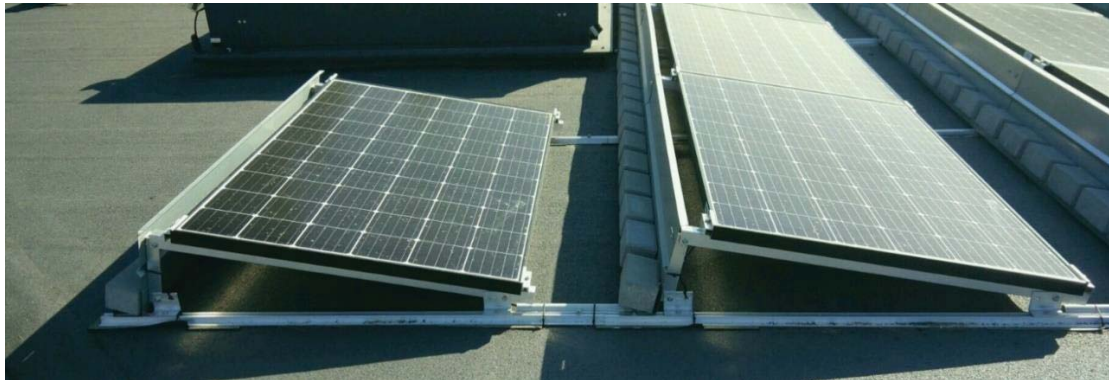
Fig. 4 Exemple de fixació de l'estructura
