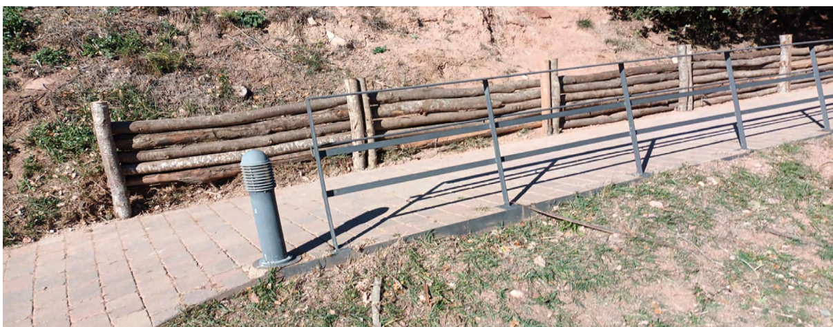
Construcció d'una palissada per a la contenció del talús d'accés a la Pastora. Font: Arxiu PNSLMO
