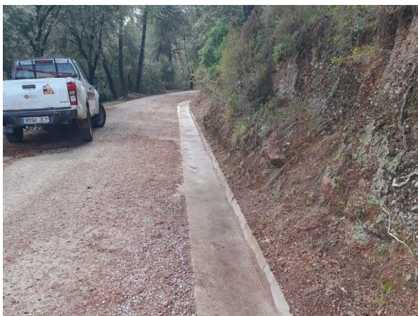
Arranjament i neteja de la cuneta del camí d'accés a la Casa Nova de l'Obac. Font: Arxiu PNSLMO
