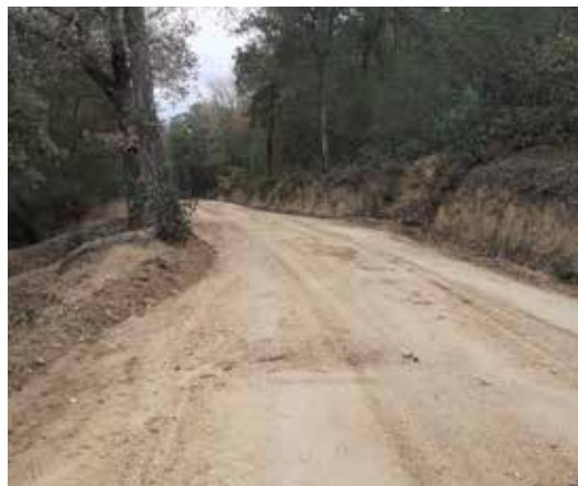
Arranjament de la pista del Santuari del Corredor. Font: Arxiu XPN
