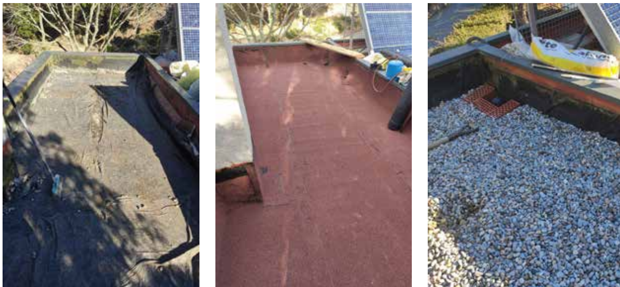
Imatges de l'estat inicial, de la col·locació de la tela asfàltica i amb la grava. Autor: XPN
