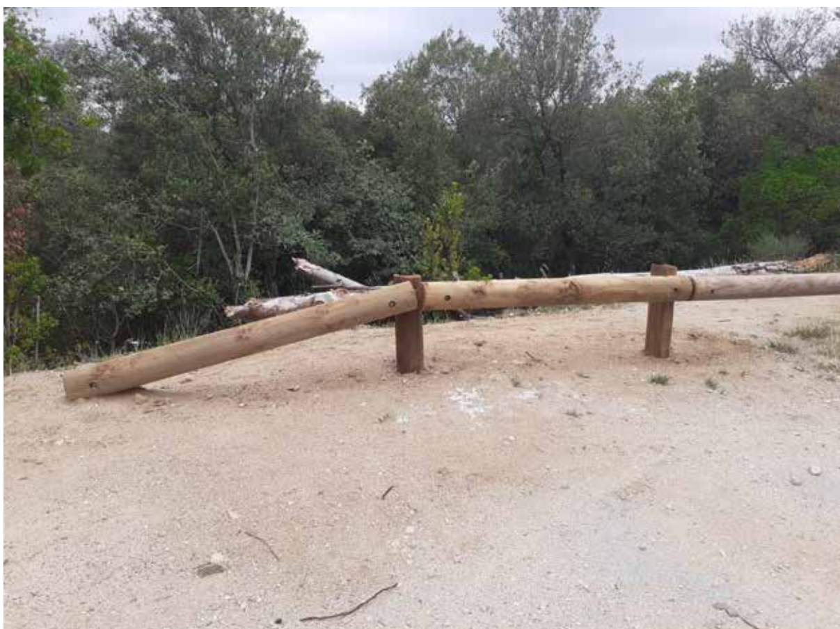
Reparació bionda a la pista del Santuari del Corredor. Font: Arxiu XPN
