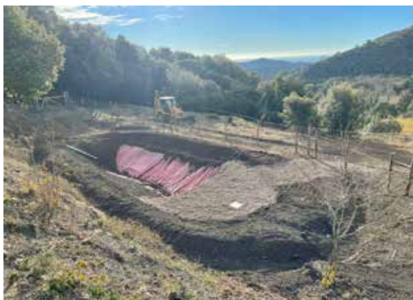
Estat del sistema de llacunatge de Can Pica. Font: Arxiu XPN
