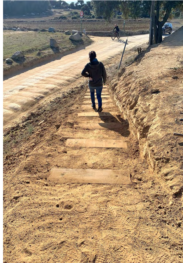
Consolidació del talús. Font: Arxiu XPN
