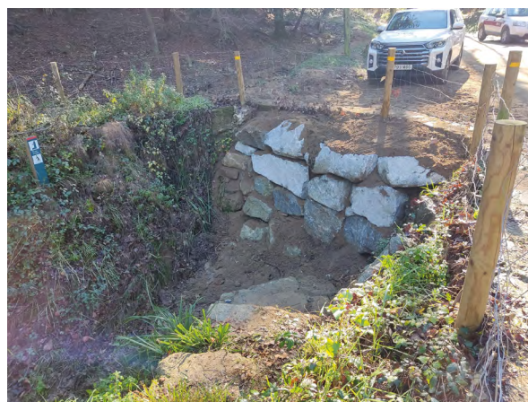
Reconstrucció d'escullera a la Font d'en Mamet. Font: Arxiu XPN
