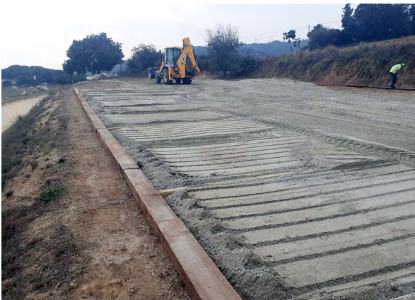
Treballs d'anivellació del terreny. Font: Arxiu XPN
