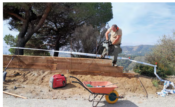
Arranjament del muret de contenció al mirador de la Cornisa. Font: Arxiu XPN
