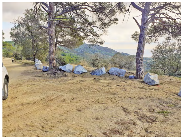
Col·locació de rocs granítics als marges de la pista carenada (Cabrils). Font: Arxiu XPN
