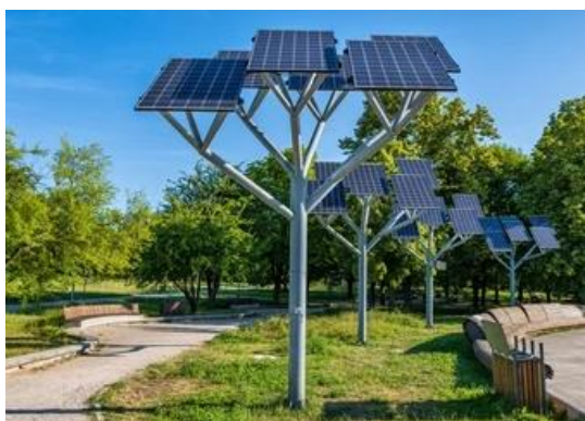
Instal·lació específica sense afectar ús
