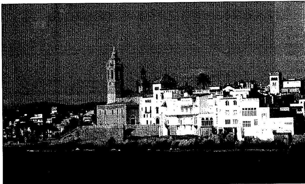
La façana marítima dels museus és la part més malmesa de tot el conjunt patrimonial de Sitges
