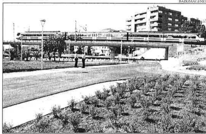
El nuevo viaducto ha liberado espacio para uso ciudadano
