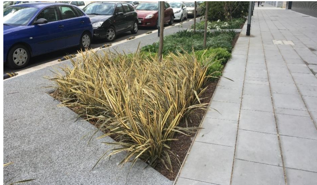
Imagen 36. Áreas de biorretención en el barrio de Bon Pastor, Barcelona.
