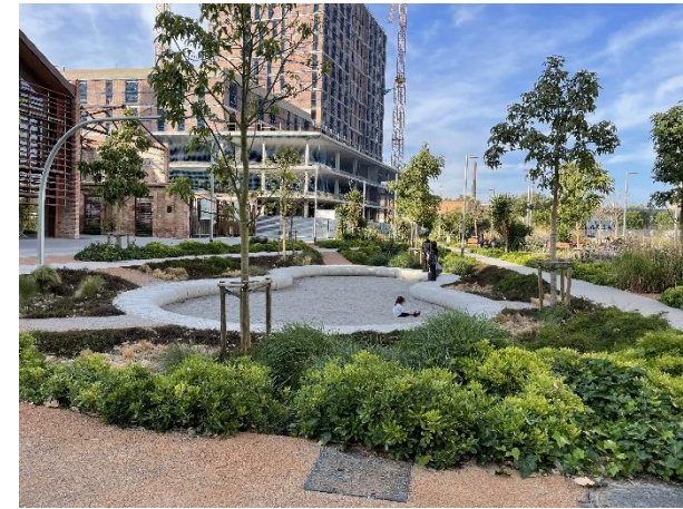
Balsa de infiltración en Moura, Barcelona.
