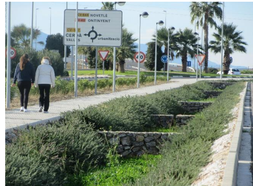
Imagen 37. Cuneta vegetada con represas en Xàtiva (Valencia).
