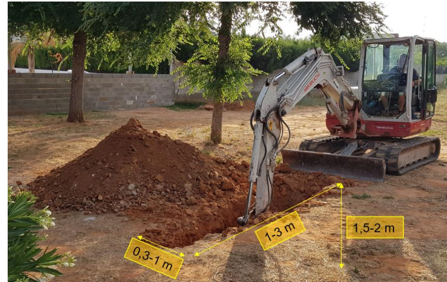
Figura 35. Valores orientativos de la zanja para el test BRE365.
