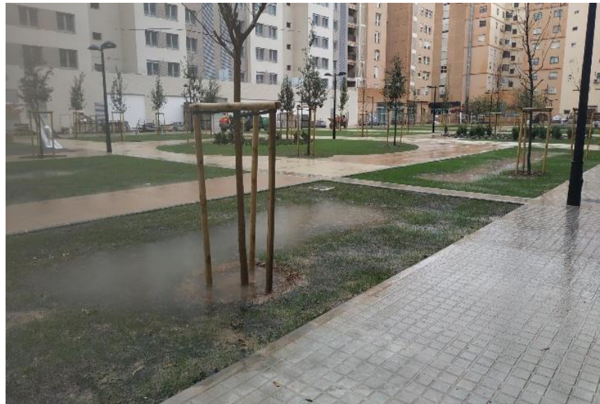
Imagen 26. Jardines de lluvia en la urbanización interior de nuevos edificios en la avenida Ausiàs March durante un evento de lluvia.
