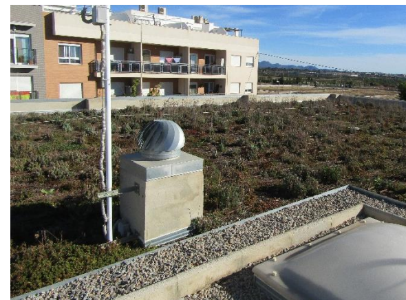
Cubierta vegetada en Benaguasil (Valencia).
