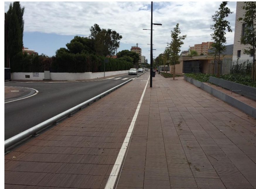
Imagen 43. Pavimento permeable cerámico en el área residencial de Benicàssim (Castellón).
