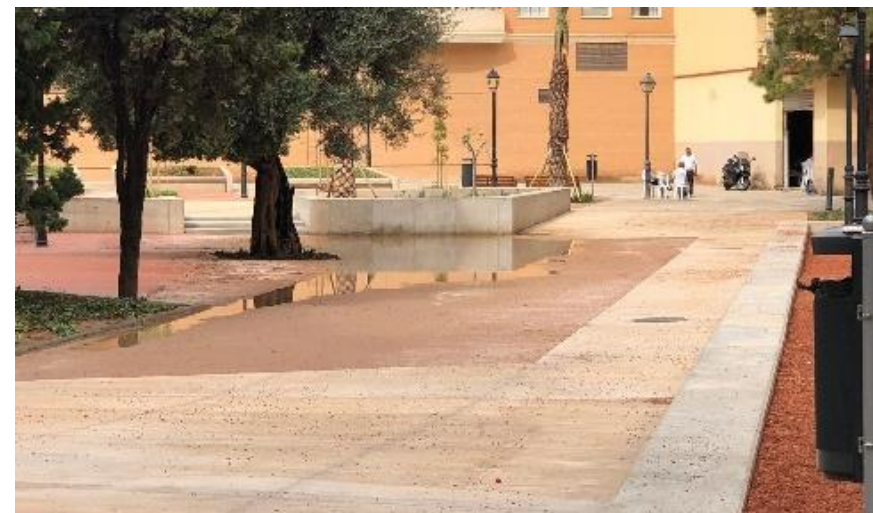
Imagen 31. Infiltración progresiva de la escorrentía tras finalizar el evento.
