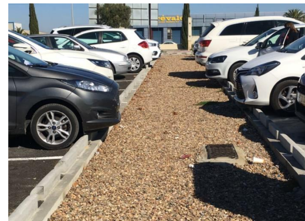
Zanja de infiltración en Alcalá de Guadaíra (Sevilla).
