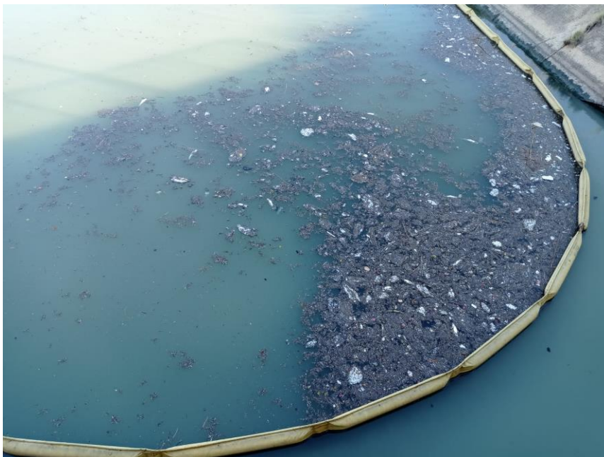
Imagen 5. Flotantes interceptados antes de la descarga al medio receptor.
