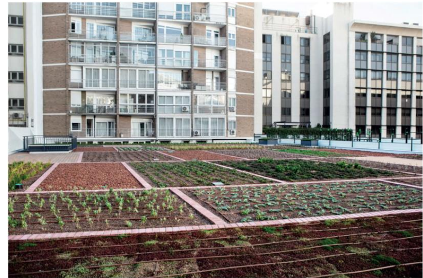
Imagen 45. Cubierta vegetalada sobre un supermercado en Madrid. Fuente: Mercadona.
