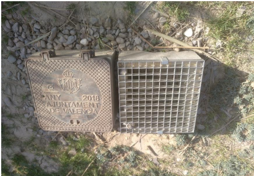
Imagen 16. Estructura de rebose en el Parc Central de València.
