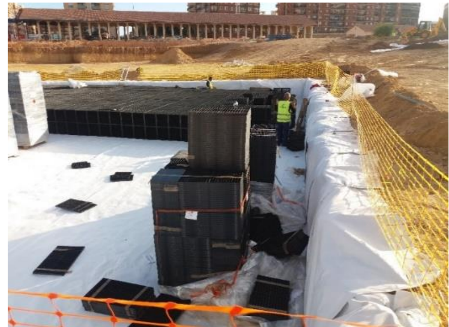
Imagen 19. Montaje de un depósito reticular sobre el geotextil.
