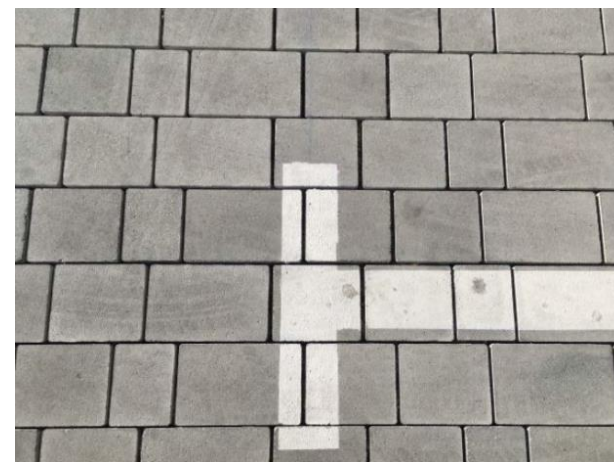
Pavimentos permeables en el Parc Esplai de Bétera (Valencia).
