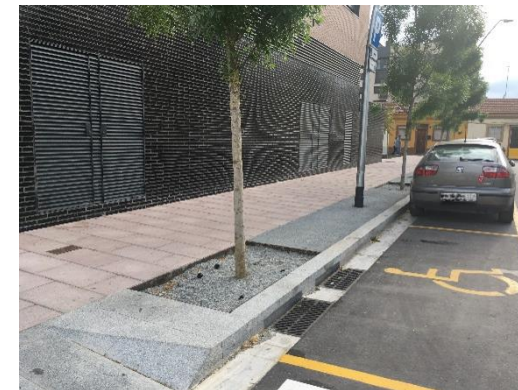
Alcorques estructurales en Bon Pastor, Barcelona.
