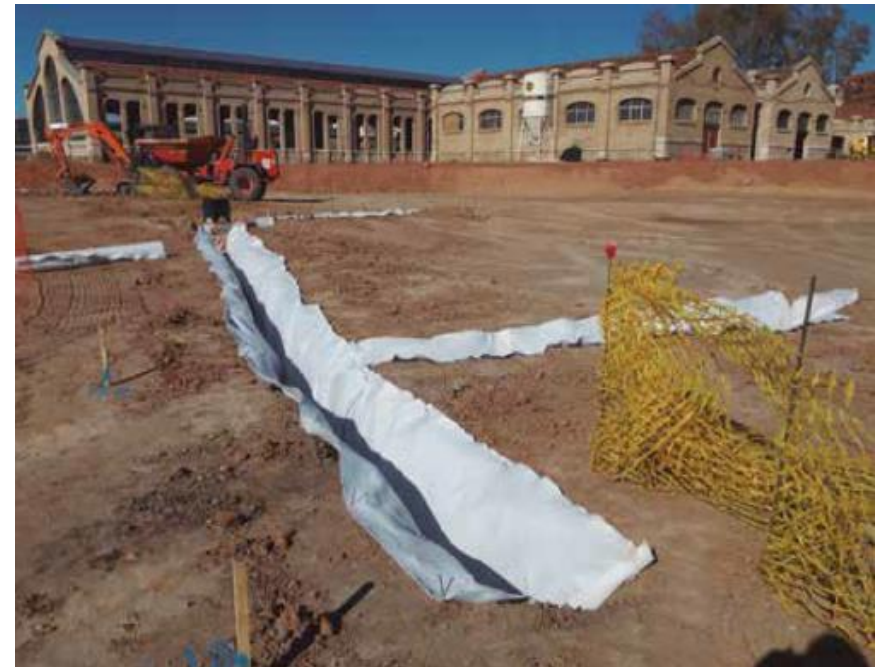
Imagen 20. Construcción de drenes filtrantes en el Parc Central.
