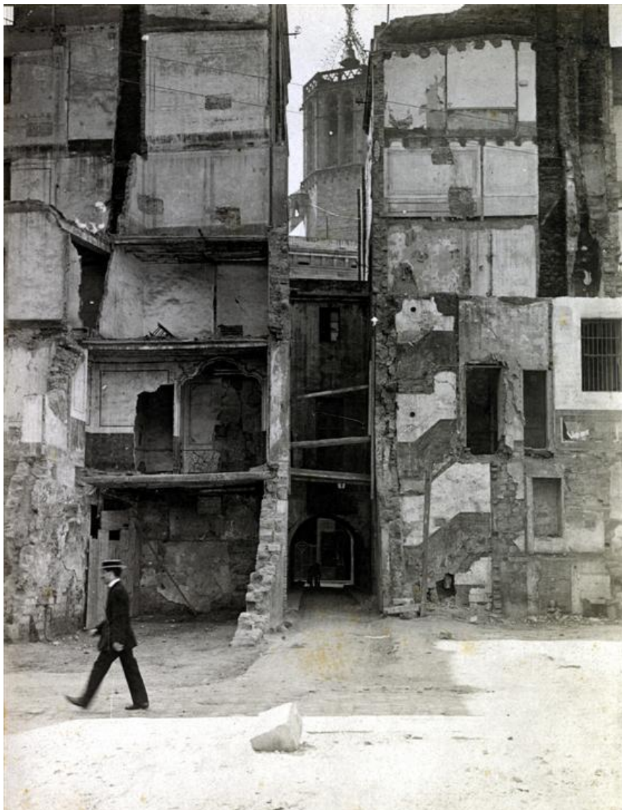
Obertura de la Via Laietana (1908-1913)
