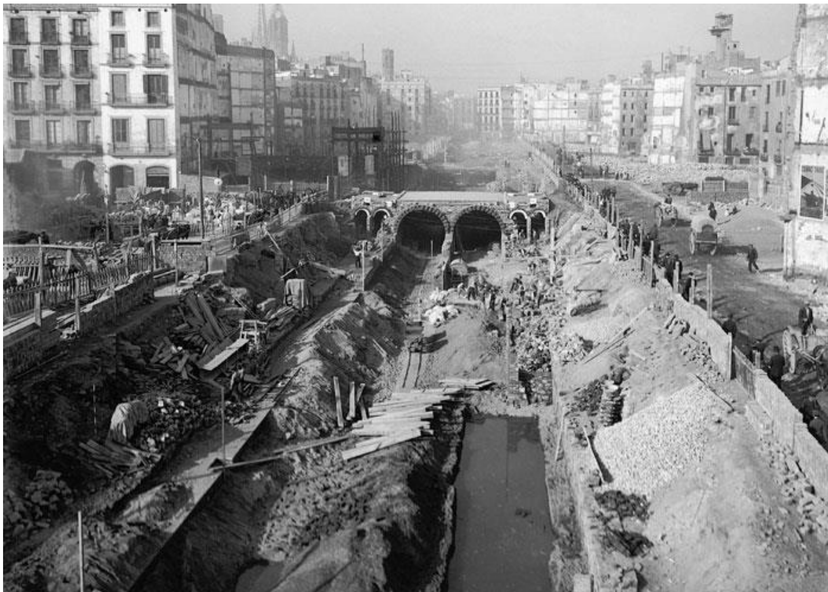
Obertura de la Via Laietana (1908-1913)
