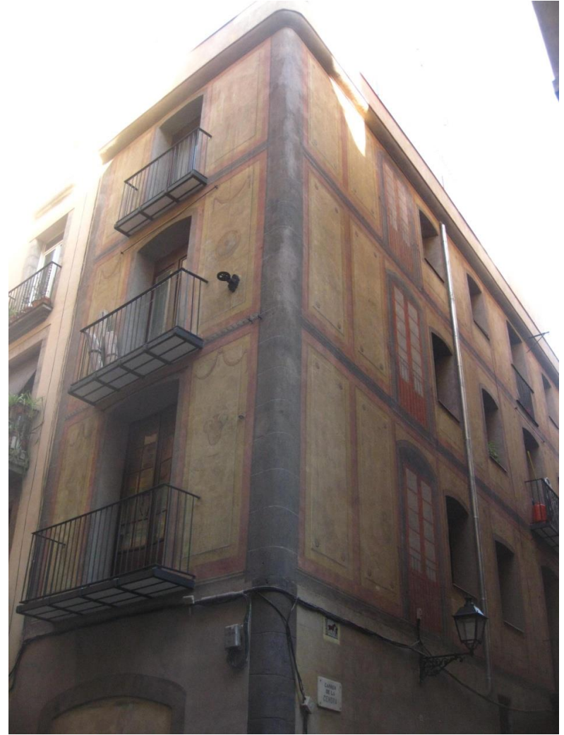
Restauració d'una façana del Raval amb simulacions murals de principis del segle XIX
