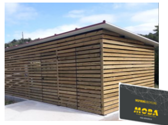
ÀREES TANCADAES AMB CONTROL D'ACCÉS
