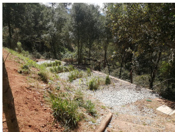
Aiguamoll del sistema de depuració de les aigües residuals del conjunt de l'Obac després de la restauració. Font: Arxiu XPN
