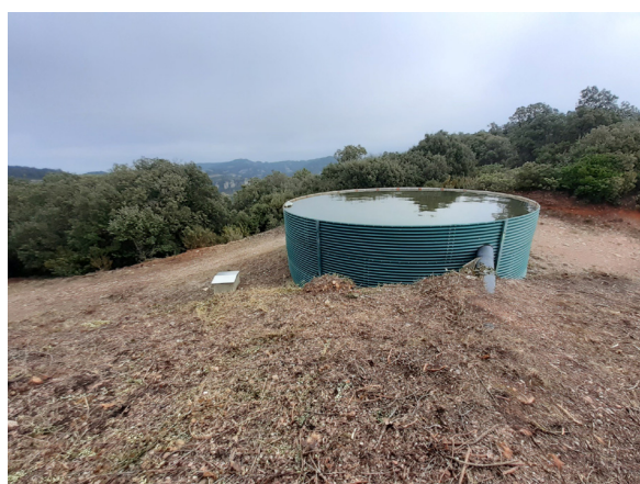
Treballs de manteniment de la bassa del turó de les Tres Creus. Font: Arxiu XPN
