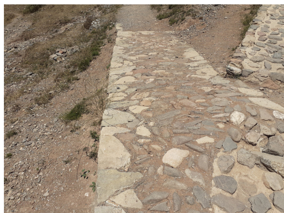
Construcció d'una rampa empedrada als entorns de la Mola. Font: Arxiu XPN
