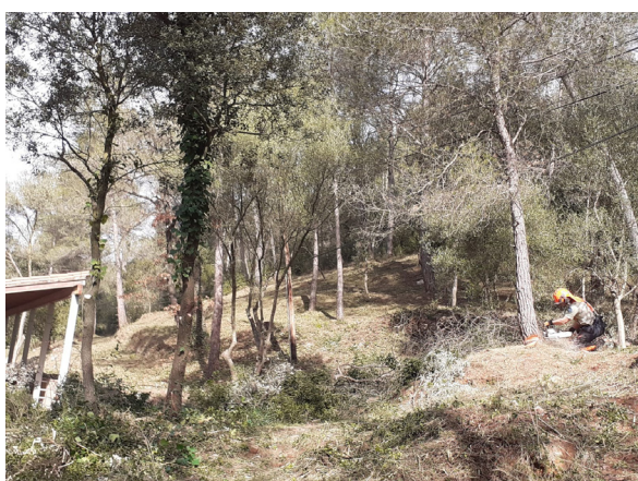
Execució de la franja de baixa combustibilitat de l'àrea d'esplai de les Arenes. Font: Arxiu XPN
