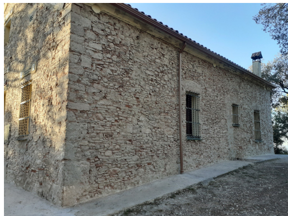
Façana del Xalet de l'Obac després de les obres de rehabilitació. Font: Arxiu XPN
