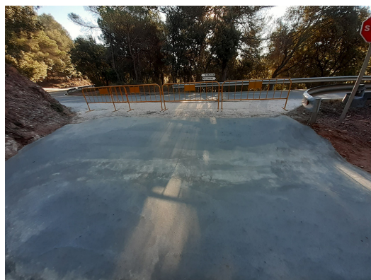
Sortida del camí de l'aparcament del conjunt de l'Obac un cop finalitzada la pavimentació. Font: Arxiu XPN
