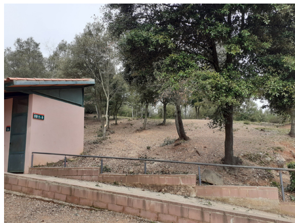
Treballs de manteniment de la franja de baixa combustibilitat de l'àrea d'esplai del Torrent de l'Escaiola. Font: Arxiu XPN
