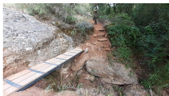
Construcció d'una passera de fusta a l'itinerari que passa pel safareig de la masia de Mata-rodona i va cap a la Morella. Font: Arxiu XPN
