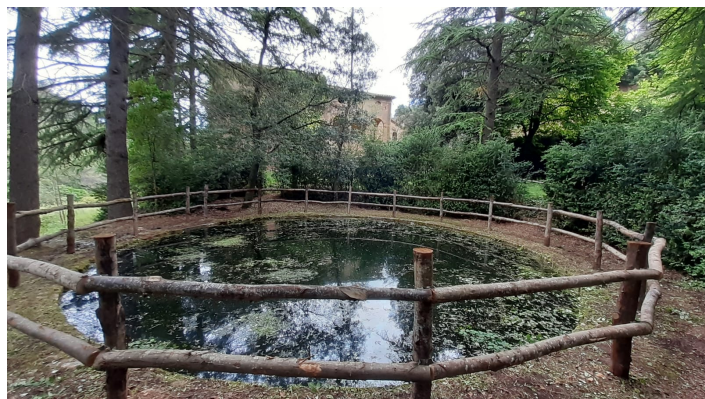
Instal·lació d'una barana de fusta al voltant de la bassa de la casa de la Vall. Foto: Arxiu XPN
