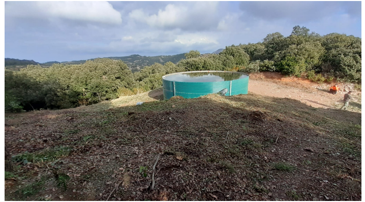
Treballs de manteniment de la bassa del turó de les Tres Creus. Foto: Arxiu XPN.
