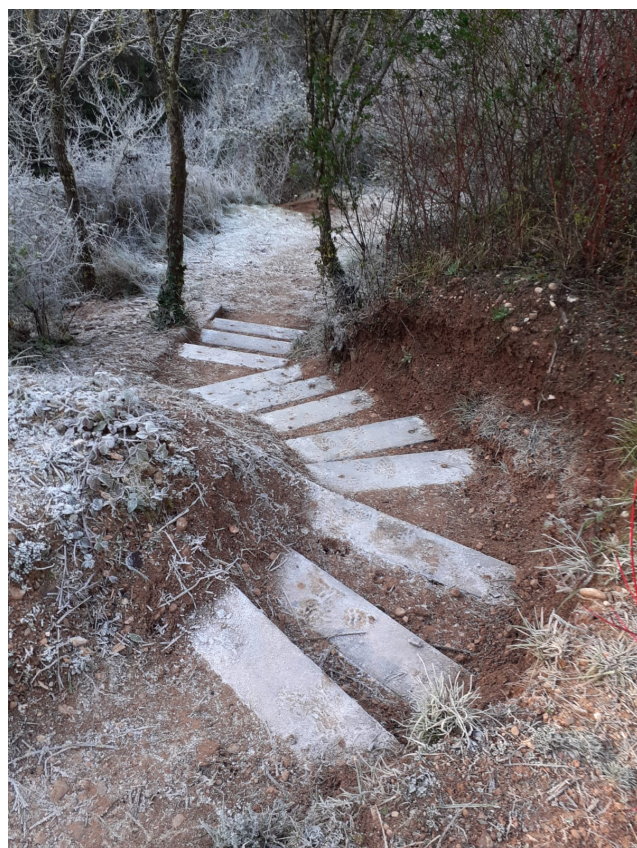
Restauració de les escales de l'itinerari SL-C66 de Mura . Foto: Arxiu XPN
