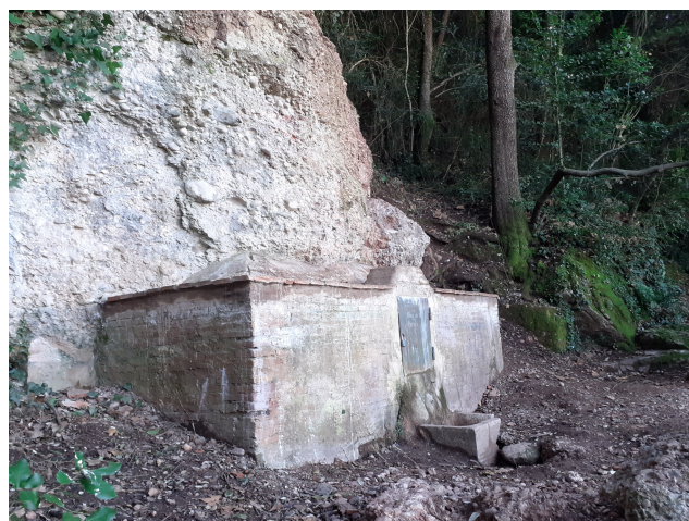
Font de la Portella després de les obres de restauració. Foto: Arxiu XPN.
