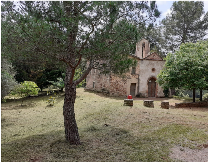
Desbrossament dels entorns de l'ermita de les Arenes. Foto: Arxiu XPN.
