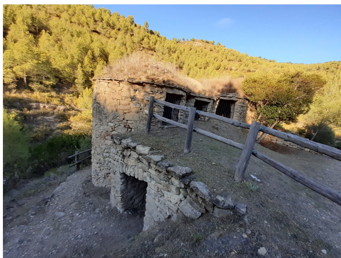
Restauració de les tines de la vall del Flaquer. Foto: Arxiu XPN.
