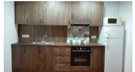
Instal·lació d'una cuina a la zona de vivenda del concessionari. Foto: Eva Arbat
