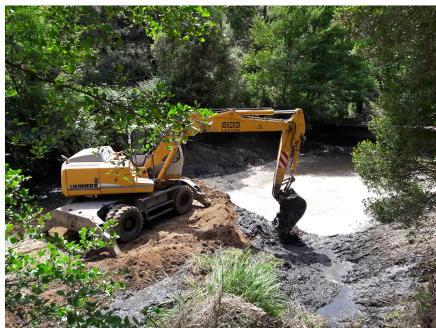
Treballs de dragatge de l'embasament del Molinot
