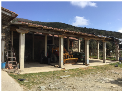
Col·locació teulada cobert Can Pla
