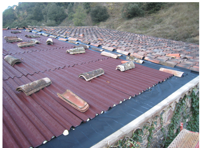
Arranjament coberta Casanova St Miquel
