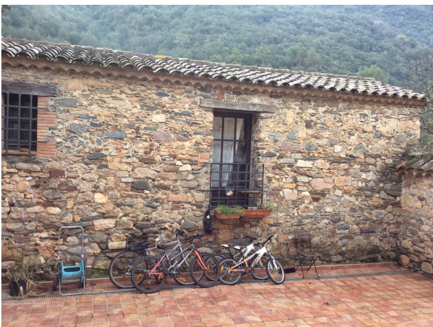
Arranjament coberta Casanova St Miquel
