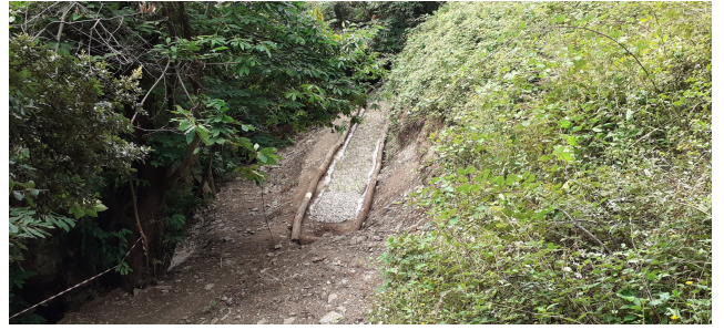
Filtre vegetal depuradora càmping Fontmartina
