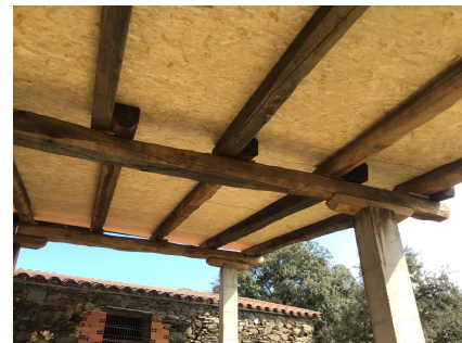
Col·locació teulada cobert Can Pla
