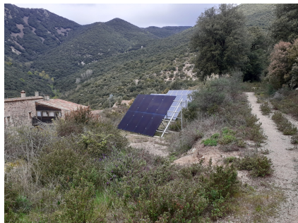
Reparació i millora instal·lació fotovoltaica masia Vallforneres
