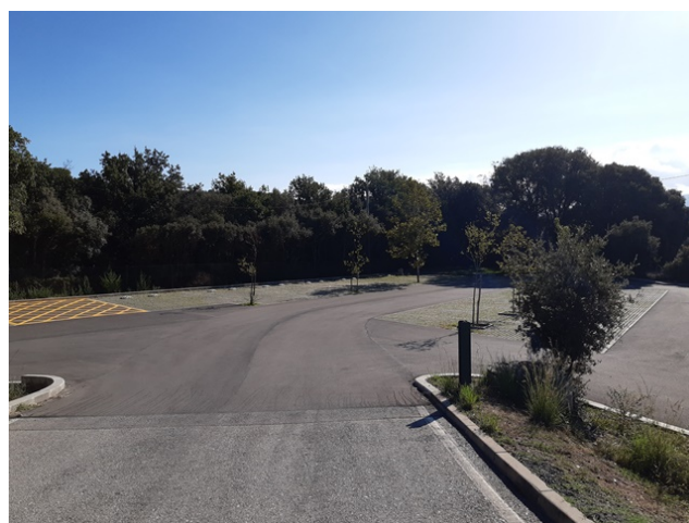
Estat final del paviment de l'aparcament del Centre d'Informació de Fogars de Montclús. Foto: Arxiu XPN
