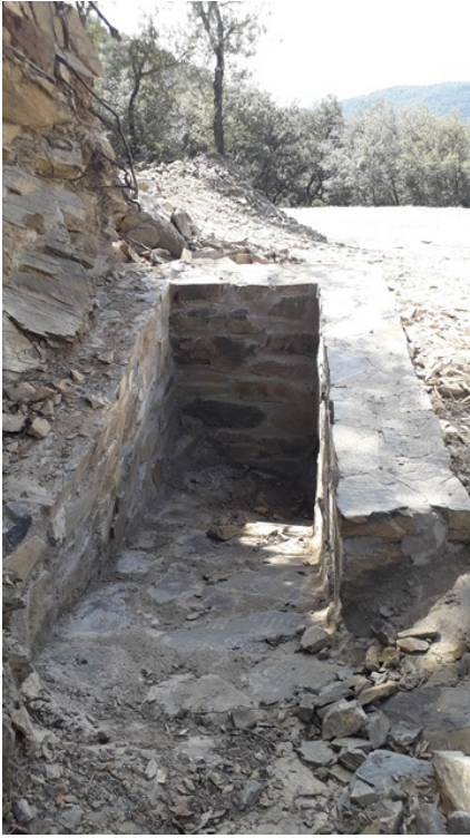
Reparació camí de Sant Salvador 3. Foto: Arxiu XPN
