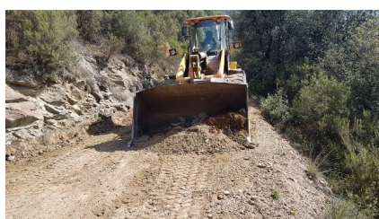
Reparació camí de Sant Salvador 1. Foto: Arxiu XPN
