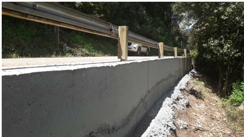
Barrera de seguretat situada al camí de Vallcàrquera 1. Foto: Arxiu XPN
