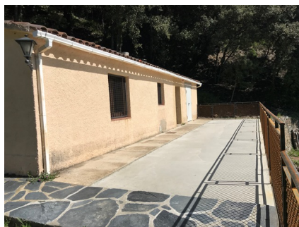
Millora i manteniment de l'Alberg Fontmartina 2. Foto: Arxiu XPN
