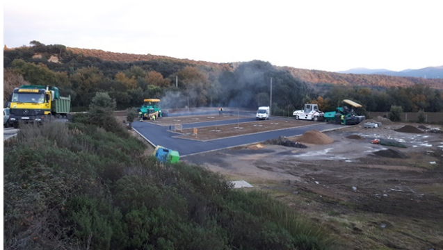
Execució de les obres a l'aparcament del Centre d'Informació de Fogars de Montclús. Foto: Arxiu XPN
