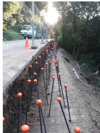
Barrera de seguretat situada al camí de Vallcàrquera 2. Foto: Arxiu XPN
