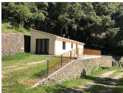
Millora i manteniment de l'Alberg Fontmartina 1. Foto: Arxiu XPN
