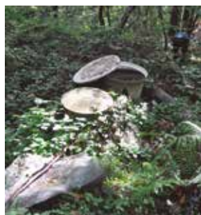
Canonades i dipòsits localitzats en un torrent amb cranc de riu, per a la captació de les aigües superficials i la seva derivació a instal·lacions particulars. (Foto: D. Guinart)
