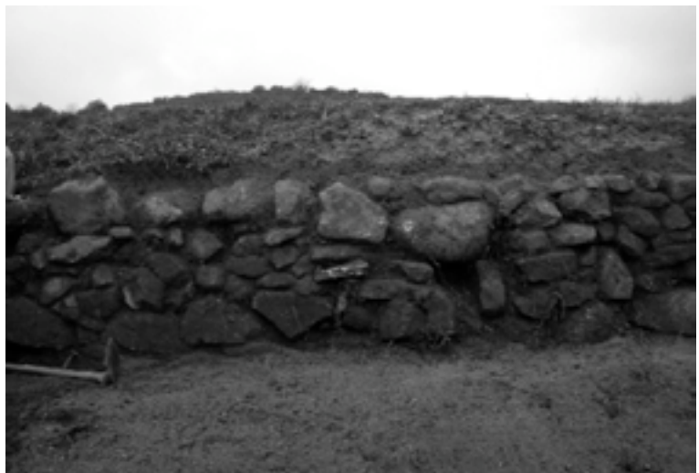
Restauració de marges
