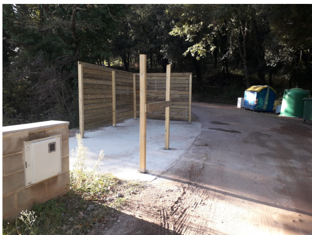
Treballs de tancament de l'àrea de contenidors. Foto: Arxiu XPN
