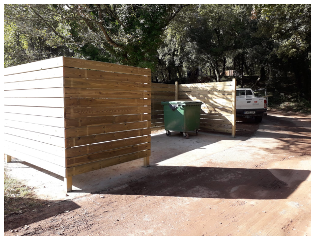
Tancament de l'àrea de contenidors del Club Nàutic de Vic. Foto: Arxiu XPN
