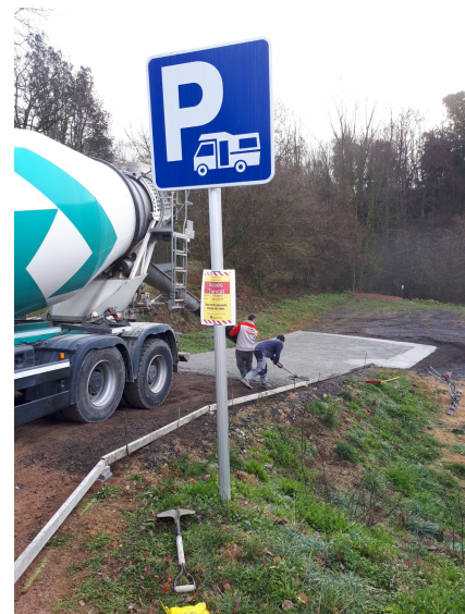
Formigonat de la rampa d'accés a l'àrea d'autocaravanes. Foto: Arxiu XPN
