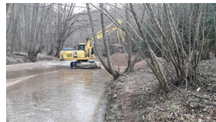
Buidat de trampes de sediments a la riera Major.
