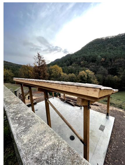
Cobert de la Solana durant la construcció. Foto: Arxiu XPN
