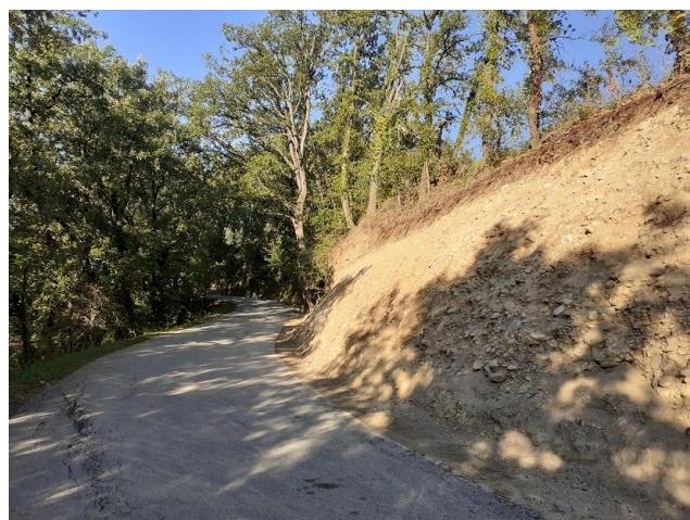
Treballs d'estabilització del talús a l'accés al parc entre la font del Castell i el mirador de Montesquiú. Foto: Arxiu XPN
