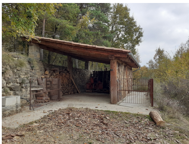
Tancament de l'antic cobert d'ovelles de la Casanova com a magatzem per a maquinària agrícola. Foto: XPN
