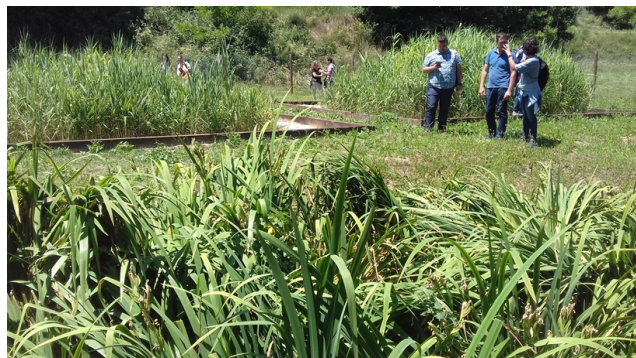
Depuradora d'aigües residuals amb filtre biològic. Foto: Arxiu XPN
