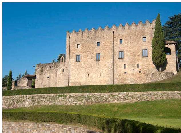
Vista del castell de Montesquiú. Foto: Arxiu XPN
