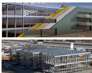
Estructuras de acero ligero, paredes de fibras
